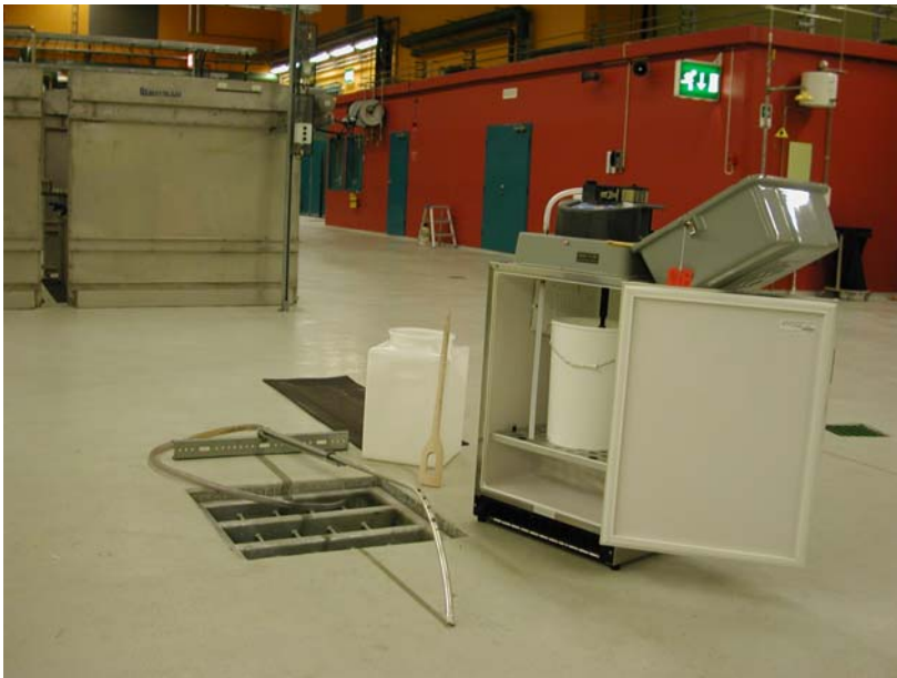
Figur B1. Tilbakeføring av spylevann fra vasking av silduk til kanal rett før sil. Merk: Under den kjemiske behandlingen ble røret forlenget, slik at vannet da gikk helt ned i vannmassene.
