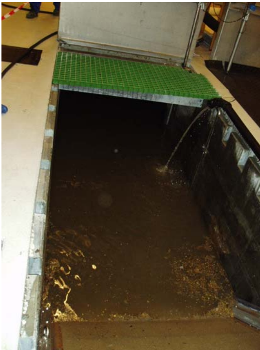
Figur B1. Tilbakeføring av spylevann fra vasking av silduk til kanal rett før sil. Merk: Under den kjemiske behandlingen ble røret forlenget, slik at vannet da gikk helt ned i vannmassene.
